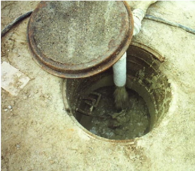
Kanalverfüllung
