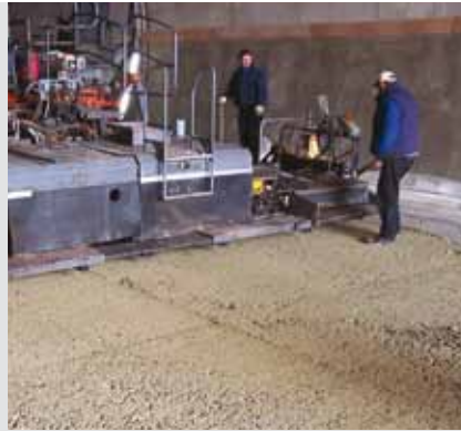
Einbau und Kerben einer HGT
