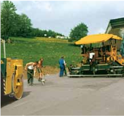
Einbau und Verdichtung einer Hydraulisch Gebundenen Tragschicht (HGT)
