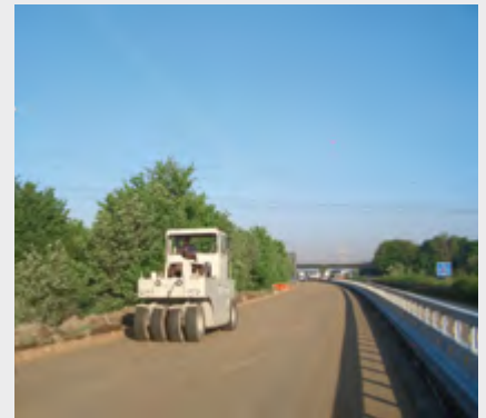
Verdichten des Planums
