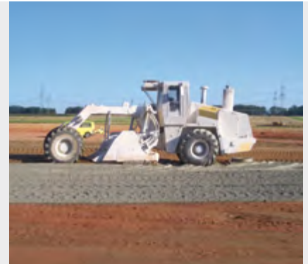
Einfräsen von Dyckerhoff VARILITH
