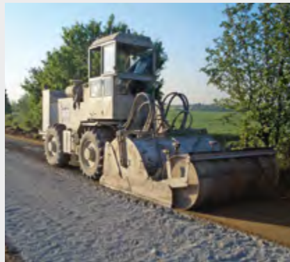
Planieren nach dem Einfräsen
