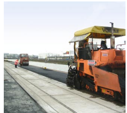
Traggerüstebau und Verdichtung (max. 4 t ohne Vibration!)
