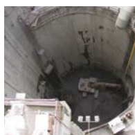
1. Seattle, USA, Beacon Hill Tunnel, Verfestigungsinjek- tion zur Ausbruchs- sicherung
