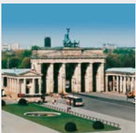
4. Berlin, Deutschland, Brandenburger Tor, Unterfangung von Gebäudeteilen
