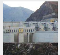
7. Muratlin, Türkei, Hydropower Station, Firstspaltverpressung beim Überlaufstollen
