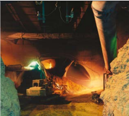
Abdichtungsinjektionen in Fels
