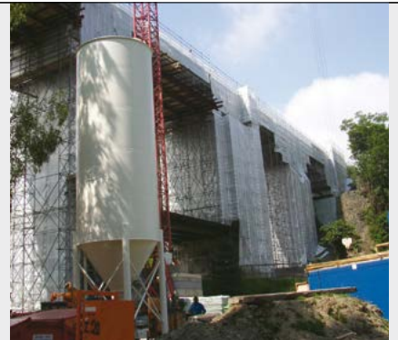
Beton- und Mauerwerkssanierung
