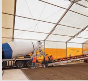
Einbau des hochfesten Betons...
