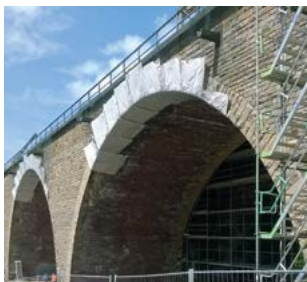
Sanierung des Mauerwerks der Brücke Einsiedelstein im Zuge der BAB 1
