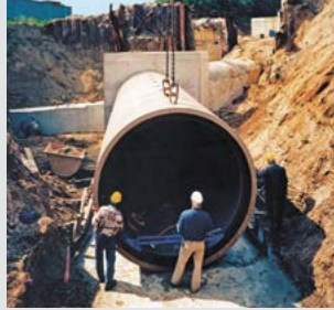
Herstellung von Betonrohren
