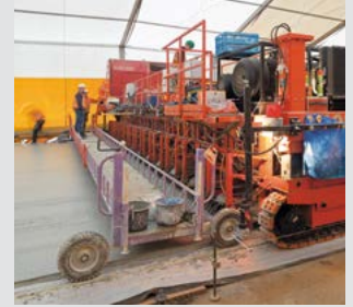
...mit speziellem Fertiger
